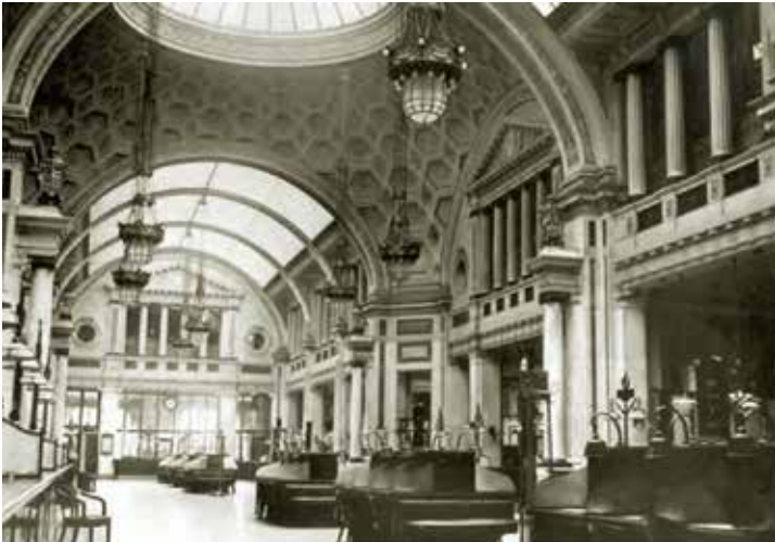
Große Kassenhalle der Stadtzentrale Berlin in der Mauerstraße Main banking hall of the Berlin city head office at Mauerstrasse
