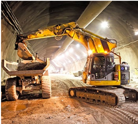
Bau eines 25 Kilometer langen Straßen- und Eisenbahntunnels in der Provinz Hatay. Construction of a 25km dual-purpose highway and railway tunnel in Hatay Province.
