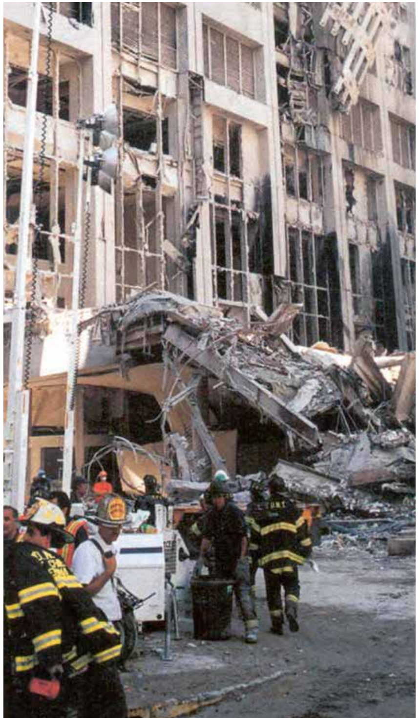
Das schwer beschädigte Bankers-Trust-Gebäude in Liberty Street nach dem 11. September The heavily damaged Bankers Trust building at Liberty Street after 9/11
