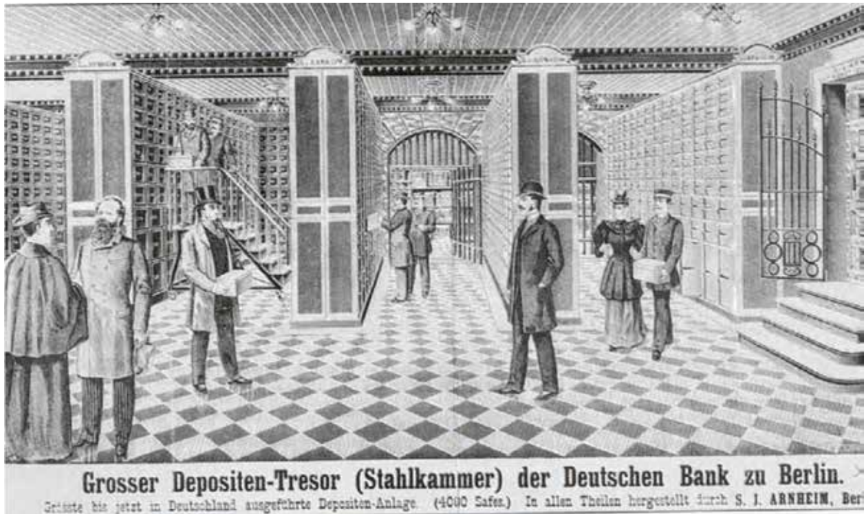
Stahlkammer in der Berliner Zentrale der Deutschen Bank Strongroom at Deutsche Bank's Berlin head office
