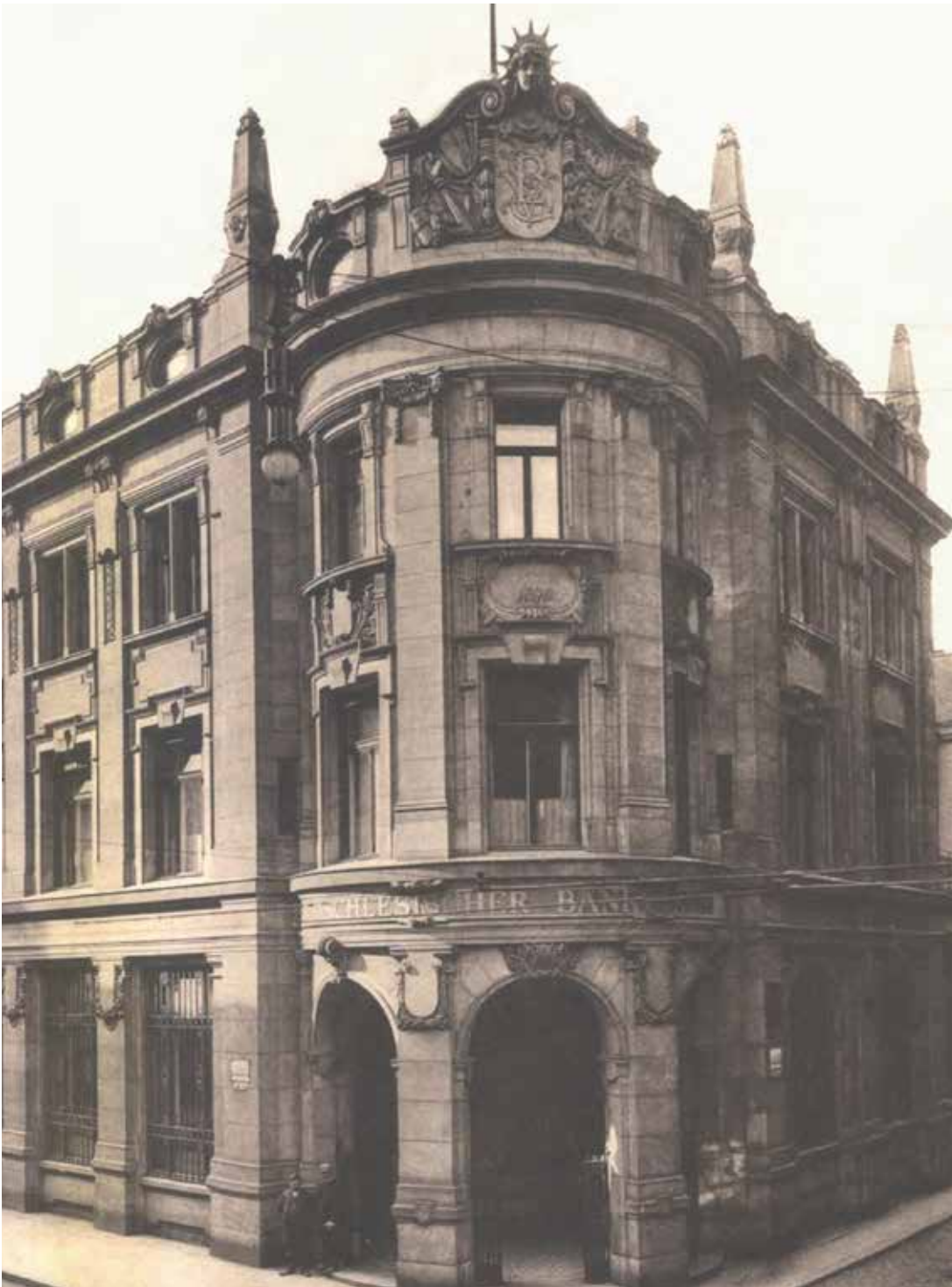
Hauptgebäude des Schlesischen Bankvereins in Breslau Main building of Schlesischer Bankverein in Breslau
